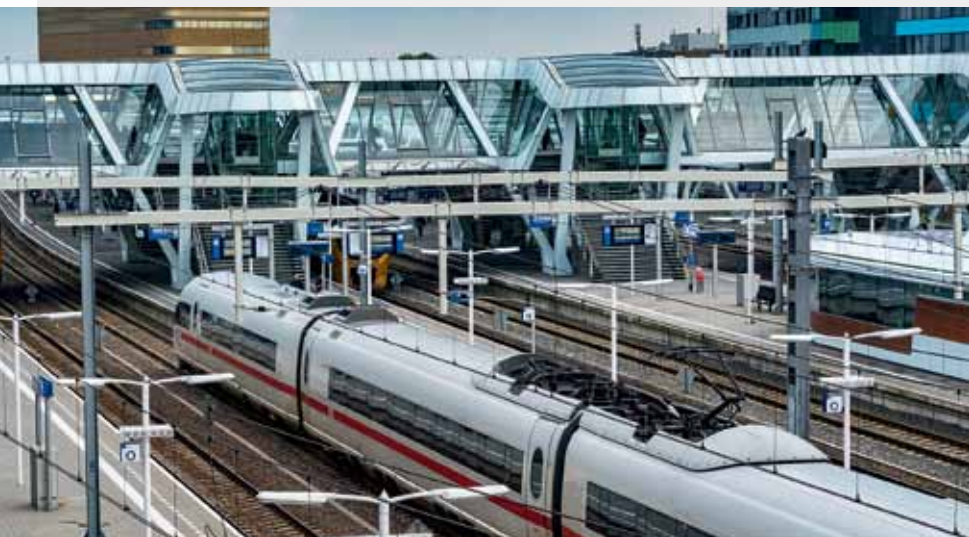
Passerelle over het spoor leidt naar ingang Sonsbeek.
