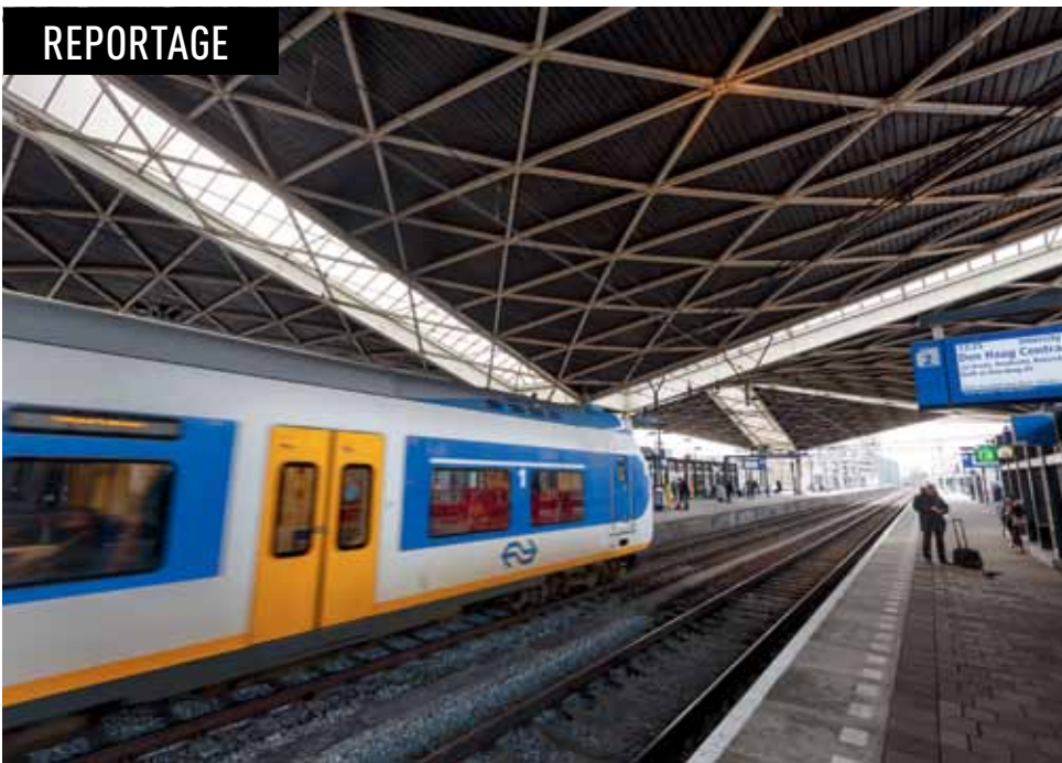
Het monumentale dak wordt gerestaureerd.
