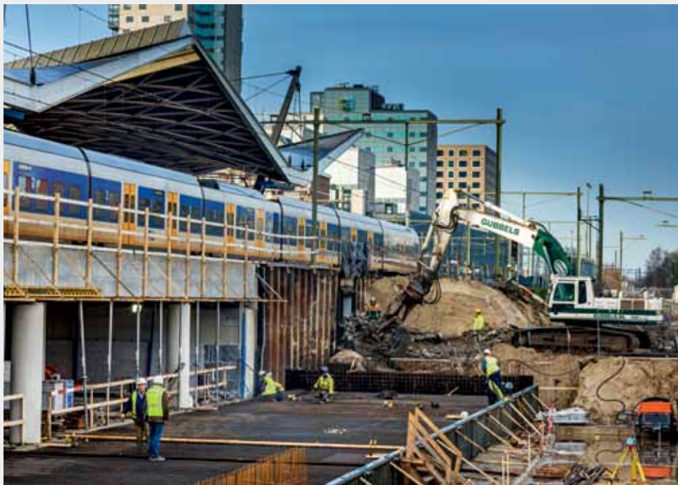
Werkzaamheden voor de bouw van het vierde perron.
