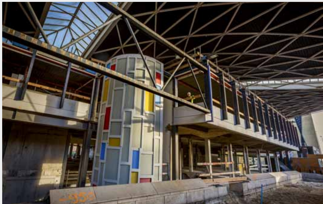
De stationshal wordt teruggebracht in de oorspronkelijke staat.
