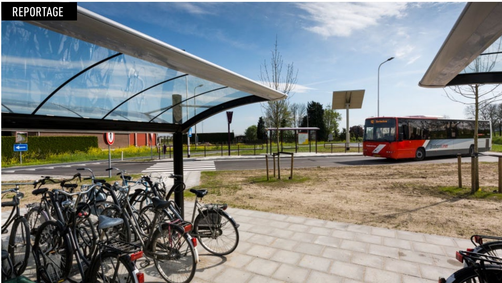
Halte Nieuwendijk is pas vernieuwd.
