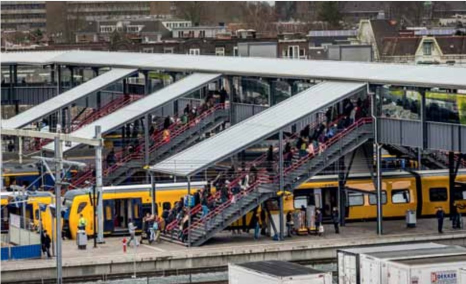
Tijdelijke traverse over de sporen.
